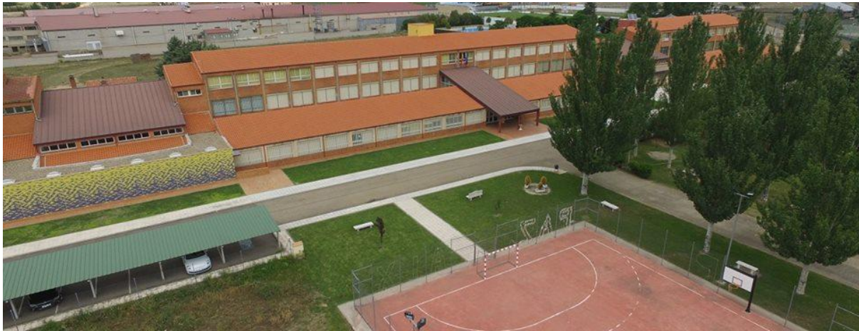
Imagen 4. Instalaciones al aire libre del IESO Los Salados
